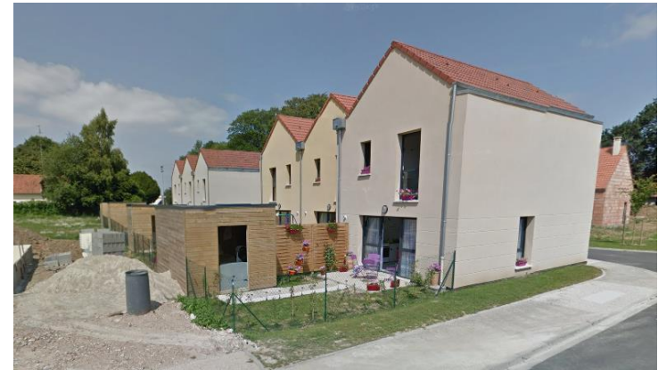
Opération de logement au sein de Feuquières-en-Vimeu – Source : google street-view
