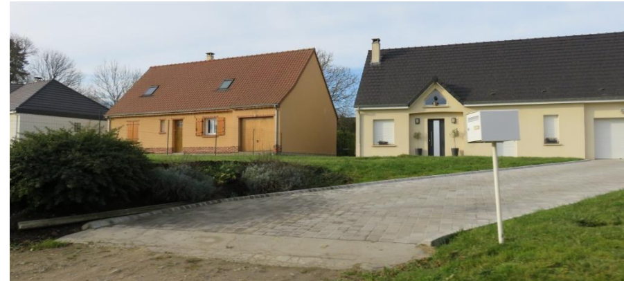
Nouvelles constructions en rupture avec les architectures historiques du territoire (source : Even conseil)
