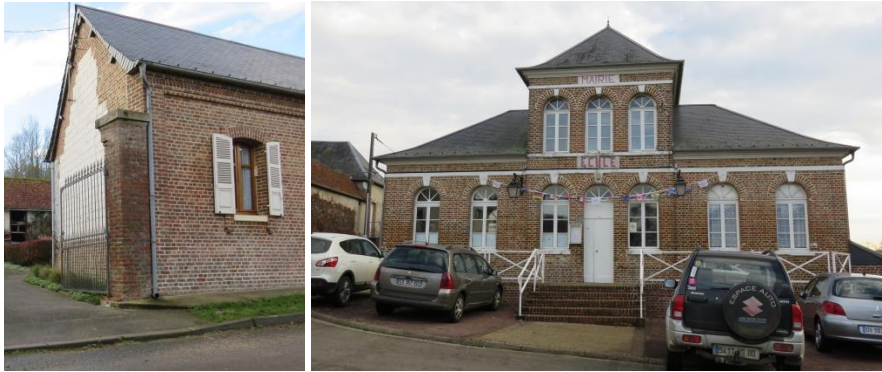
Alternance de briques d'argile et de moellons de craie
