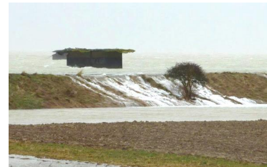
Figure 25 - Digue de la Gaité lors de la tempête Xynthia (2010) – source G.Morisseau
