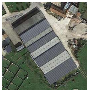
Toiture PV agricole à Bellancourt 2
