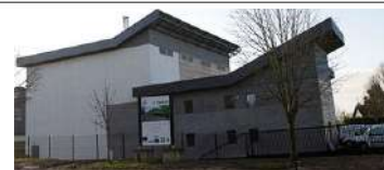
Chaufferie bois du réseau de chaleur d'Abbeville 4
