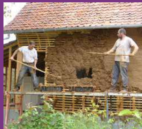
Préparation d'un mur traditionnel en torchis avant la pose de son enduit de finition.
