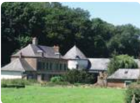
L'ensemble sur cour depuis la rue Principale
