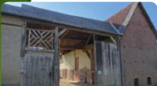
Corps de ferme rue de Friaucourt, restauré et labellisé par la Fondation du Patrimoine
