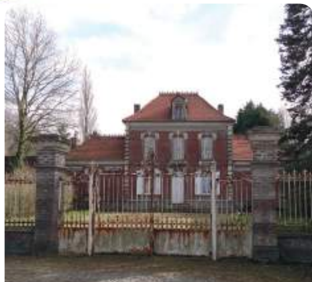
Vue du logement patronal aujourd'hui
