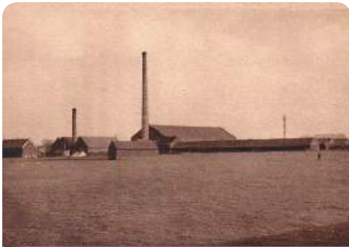
Vue de l'usine en 1920 (coll.part.)
