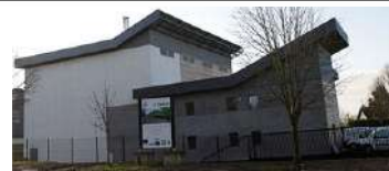
Chaufferie bois du réseau de chaleur d'Abbeville 3
