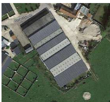
Toiture PV agricole à Bellancourt 2
