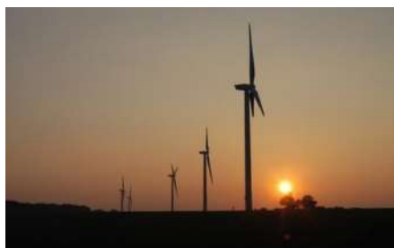
Parc éolien Les Monts Bergerons II 1
