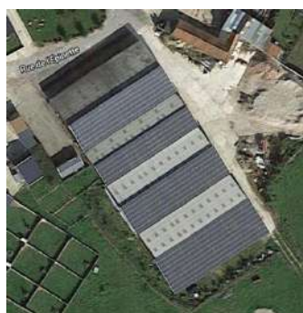
Toiture PV agricole à Bellancourt 2
