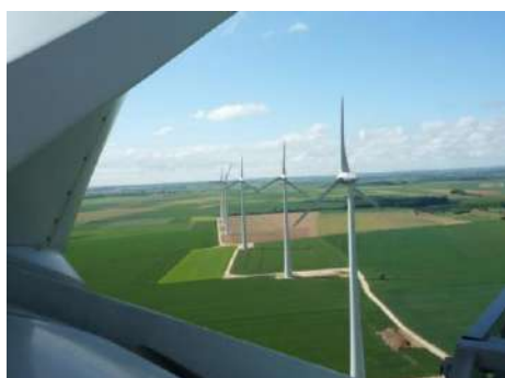
Parc éolien du Nouvion 1
