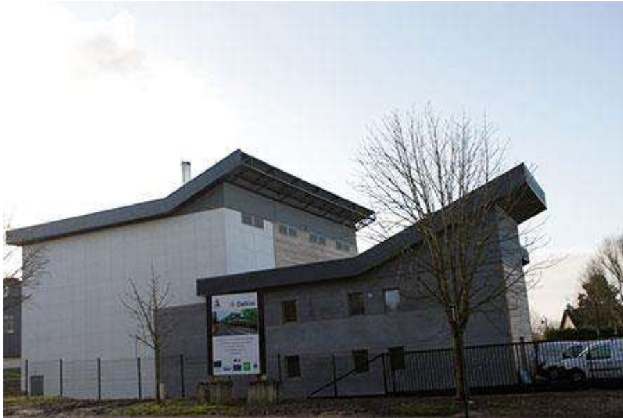
Figure 70 : Chaufferie bois-énergie du réseau de chaleur d'Abbeville.
