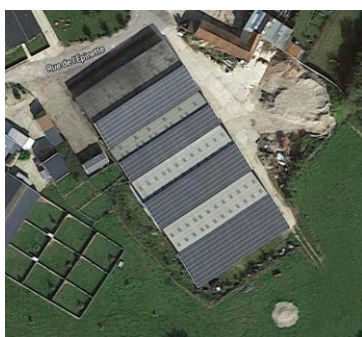
Toiture PV agricole à Bellancourt 2
