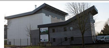
Chaufferie bois du réseau de chaleur d'Abbeville 3
