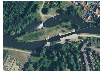
Vue aérienne de l'écluse de Pont-Rémy Google Satellite
