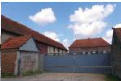
Corps de ferme Grande rue, le Festel.
