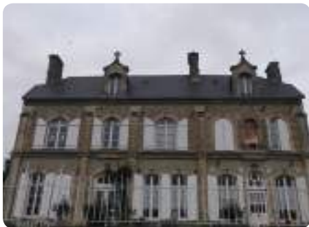
Vue de la façade principale du « château », route d'Auxi
